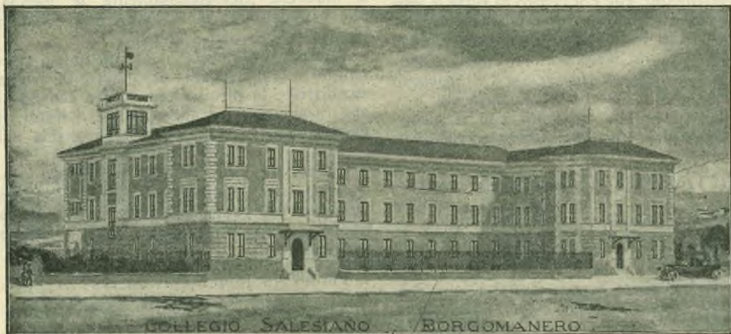
Borgomanero (Novara) - Il nuovo Collegio Salesiano in costruzione.
